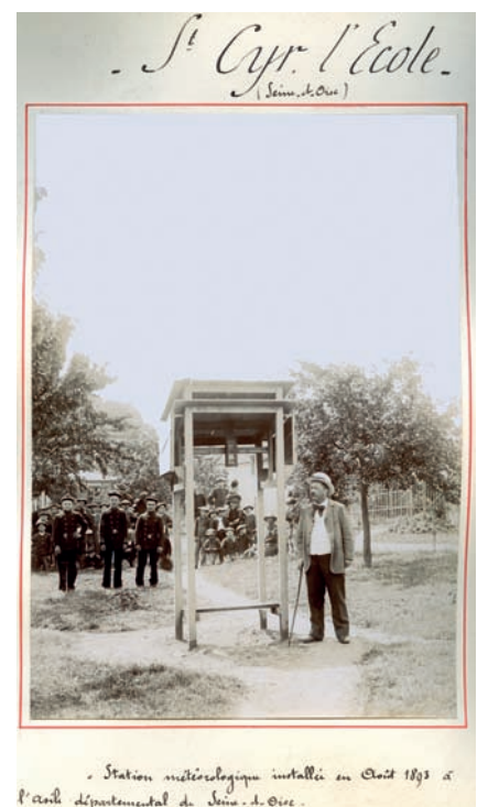
Figure 6. L'abri français ouvert, dit de Montsouris, de la station météorologique de Saint-Cyr l'École en 1899. Photo extraite d'un album de photographies des postes météorologiques de la région parisienne à la fin du XIX e siècle, conservé à la bibliothèque de Météo-France (© Météo-France).
