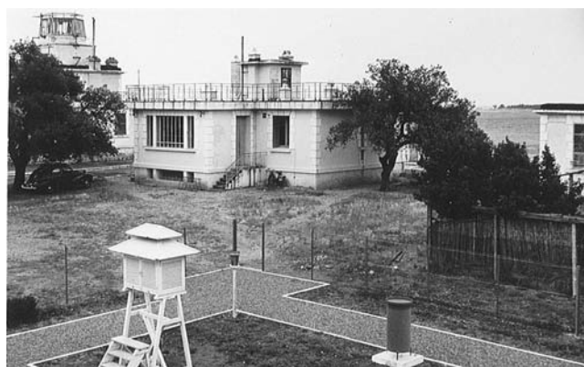
Figure 7. L'abri anglais (à double toit et à persiennes) de la station de Perpignan en 1956 (© Météo-France).
